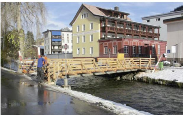
verzichtet. Der neue Holzoberbau wurde analog dem bisherigen erstellt, alles mit Lärchenholz. Die Fahrbahnbohlen sind 10 cm stark. Die Randbalken wurden mit Schrauben an den Fahrbahnbohlen befestigt. Die Geländerpfosten wurden ebenfalls mit Bauschrauben an den Randbalken befestigt. Neu wurde das Geländer mit Längsstreben ausgesteift. Die Arbeiten wurden im Spätherbst 2013 ausgeführt.
