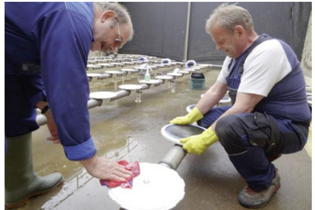
Reinigung eines Grundkörpers und Montage einer neuen Membran (schwarz)
