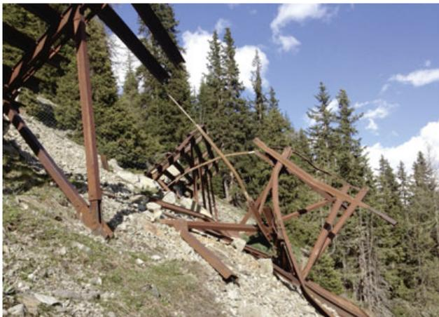
Durch den Felssturz total beschädigte Stahlschneebrücke
