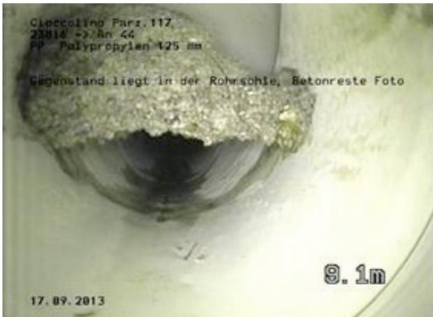
**Mangel an einer Abwasserleitung durch abgelagerten Restbeton**
