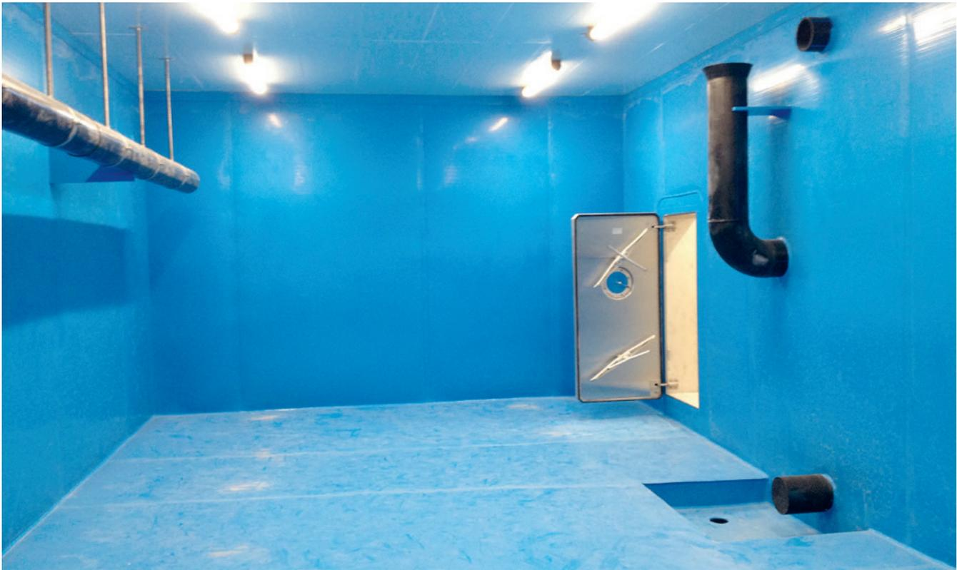
**Fertiggestellte Reservoirkammer mit Eternit-Auskleidung**
