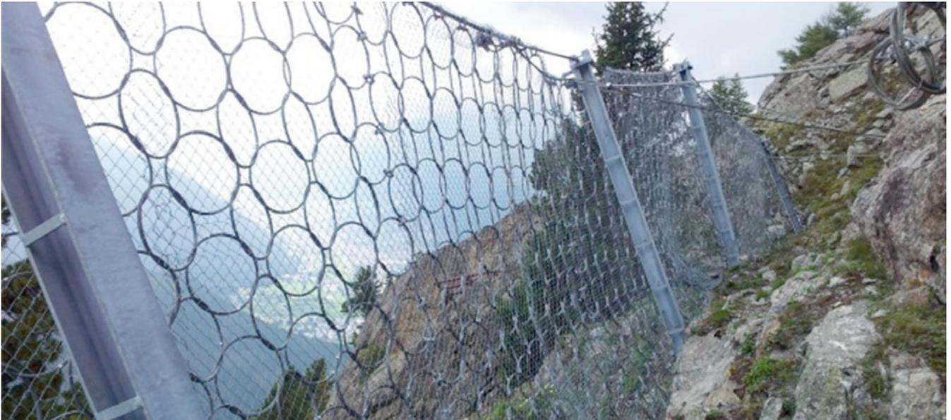
**LV Seehorn, eine Netzverbauung sichert die Ausbruchstelle vom Felssturz 2013**
