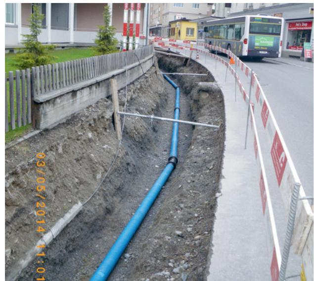
**Einbau der neuen Wasserleitung im Trottoir im Bereich der Promenade 109**
