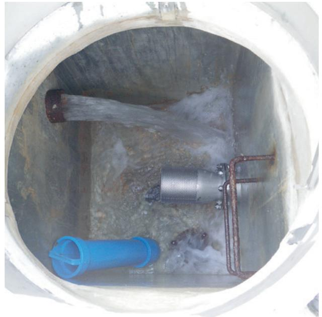
Einblick in eine Brunnenstube bei der Inneralp – links oben Eintritt des Quellwassers – rechts der Auslauf inkl. Filter in Richtung Reservoir Monstein
