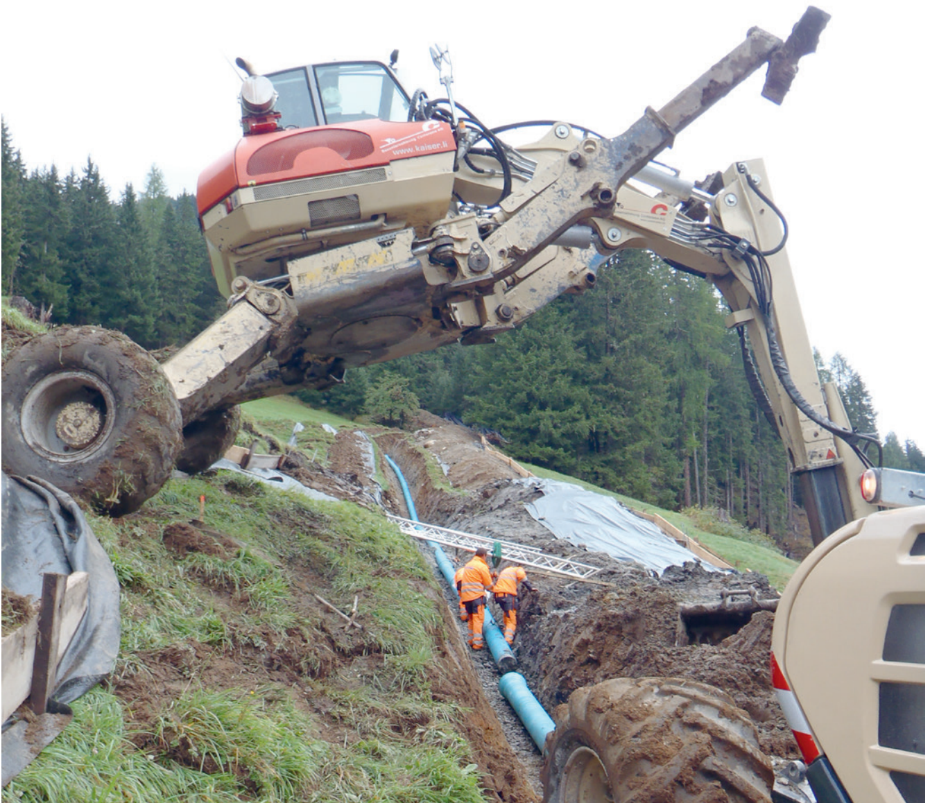
Die neue Transportleitung im steilen Leitungsgraben. Von den Maschinisten war besonderes Geschick gefordert.
