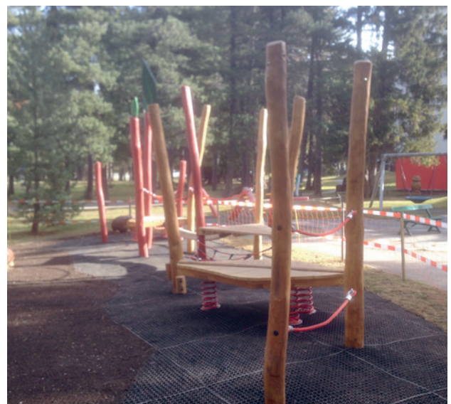
Bau der neuen Spielgeräte mit entsprechenden Fallschutzmassnahmen
