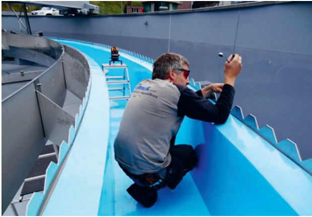
Firma Tinner GmbH bei der Höhenkontrolle der Zackenbleche.
