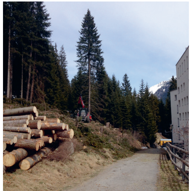
Holzereiarbeiten an der Hohen Promenade
