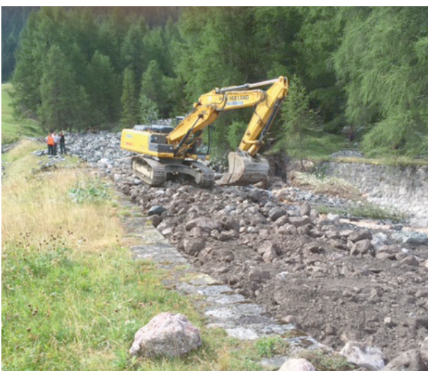
Stützalpbach, Räumungsarbeiten bei der Wasserfassung
