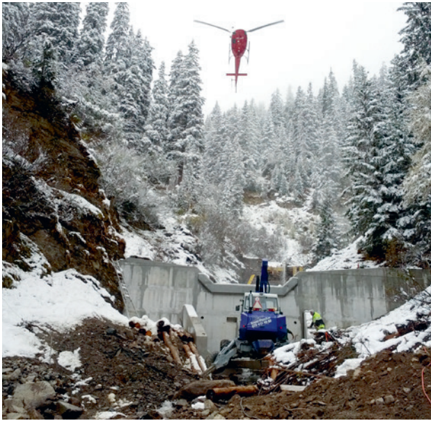
Bildjibach, Materialtransporte für die Sperrensanierung
