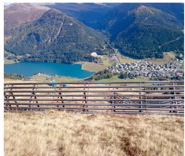
Lawinerverbauung Dorfberg, fertig montierte Stahlschneebrücken
