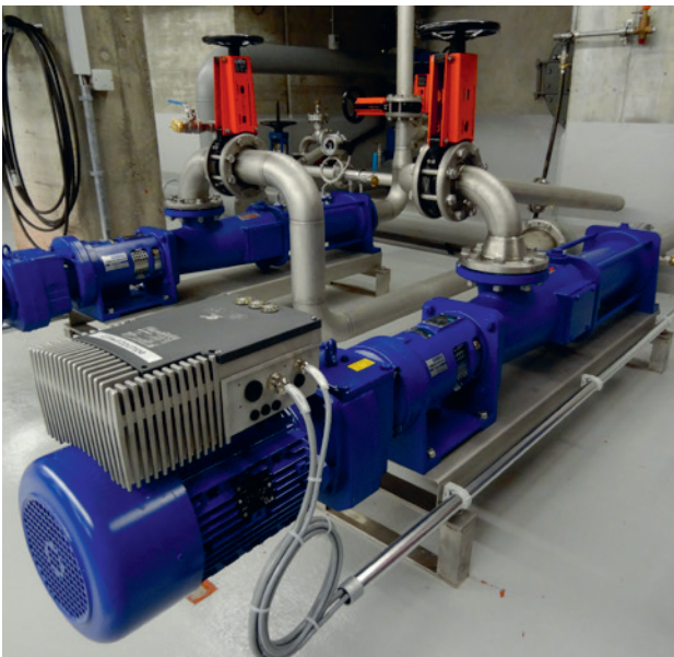
Neue Faulschlamm-Umwälzpumpe
