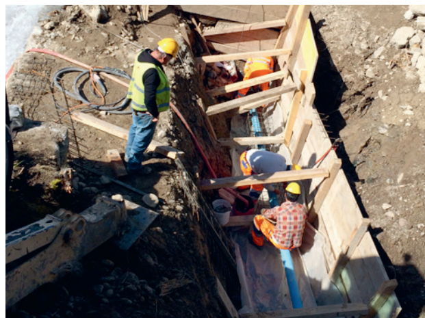
Albertibachquerung mit der Wasserleitung – im Hintergrund wird der Albertibach durch das grosse Rohr um die Baustelle geführt
