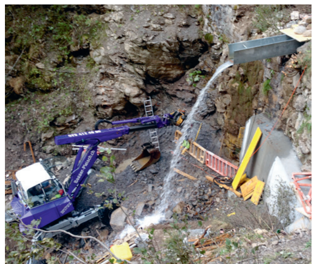
Bildjibach, Aushubarbeiten für die Sanierung einer Sperre
