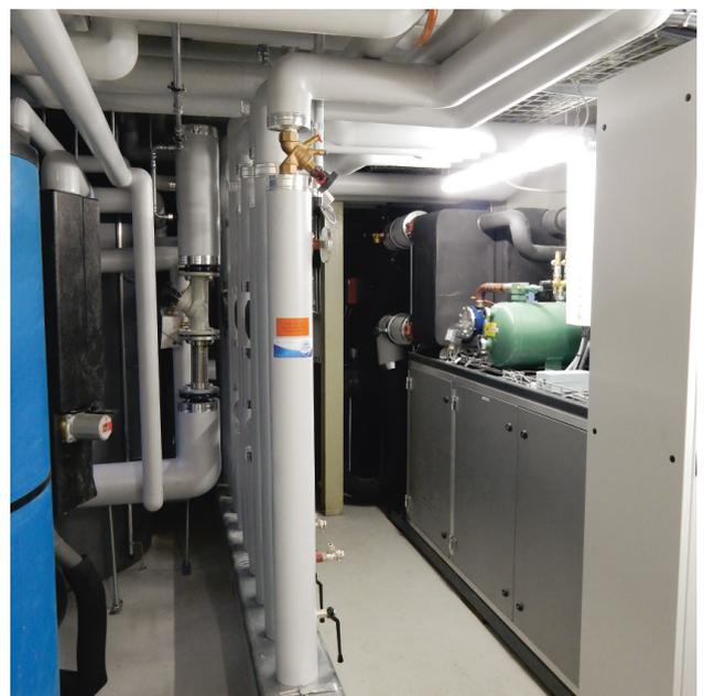
**Heizzentrale mit Wärmepumpen und Verteiler (Leistung 190 kW)**
