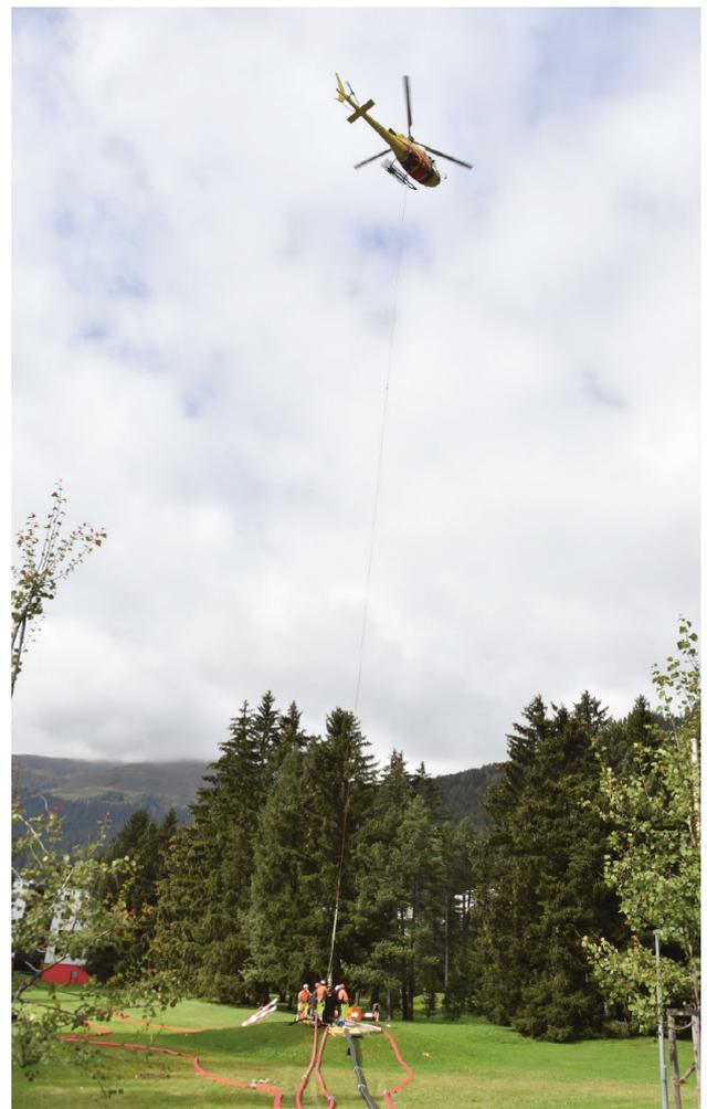
Einbau der Grundwasserpumpe in der Erkundungsbohrung im September
