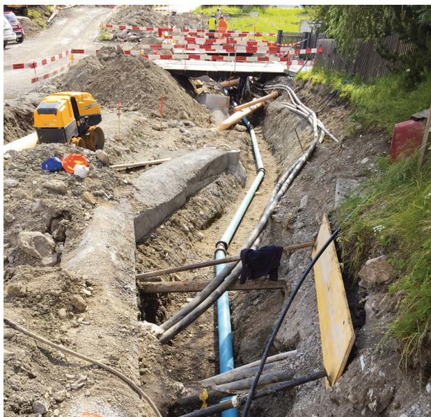
**Die neue Wasserleitung wird unter die Palüdastrasse verlegt. Links oben ist die Baupiste für den Verkehr Richtung Palüda zu sehen.**
