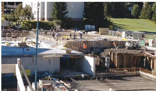
Als erstes musste der Grundwasserspiegel abgesenkt werden. Aufgrund der Witterung zu dieser Jahreszeit entpuppte sich das als ein aufwändiges Unterfangen. Es dauerte daher auch etwas länger als geplant, bis die Rohbauvollendung gefeiert werden konnte.
