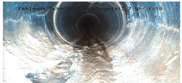
**Kanalfernsehaufnahme des Rütibachs, auf welcher die Ablagerungen auf der Sohle ersichtlich sind**
