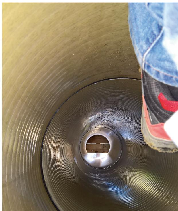
Innenansicht des Ablaufkanals während einer Rohrverlegekontrolle durch den Betriebsleiter der ARA Davos
