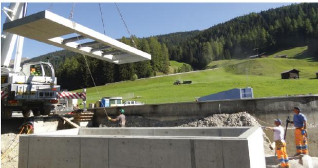
**Montage der Abdeckung des neu erstellten Wärmetauscherschachtes**
