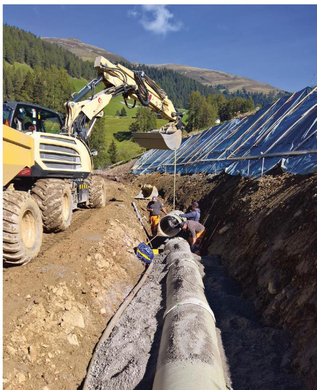
Montage der Glasfaserrohre für den neuen Ablaufkanal
