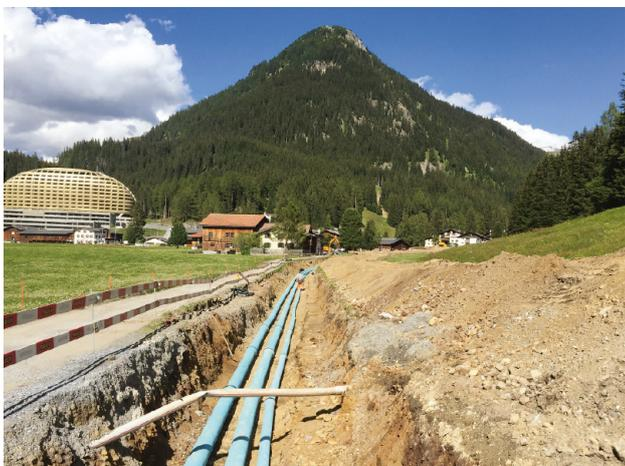
**Ansicht der neuen Leitungen im Bereich des Bedrawegs. Die beiden grösseren Leitungen links dienen der Wasserversorgung, die kleinere der Beschneigung der Langlaufloipen.**
