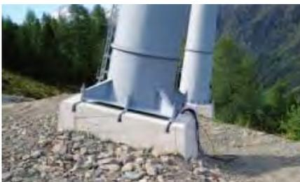
Seitenverschiebbare Seilbahnstütze auf Boden mit Permafrost (Quelle: Bommer et al. 2009)
