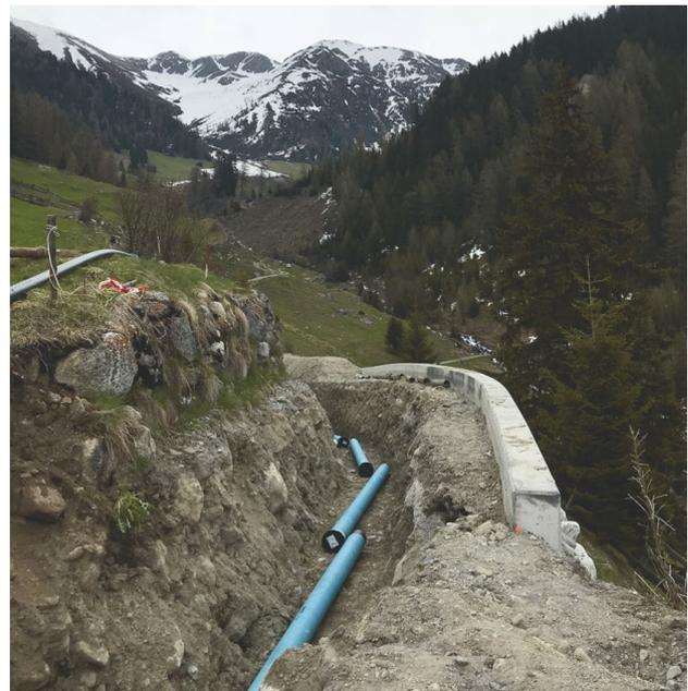
**Verlegen der Trinkwasserleitung in die zu sanierende Forststrasse Richtung Oberalp**
