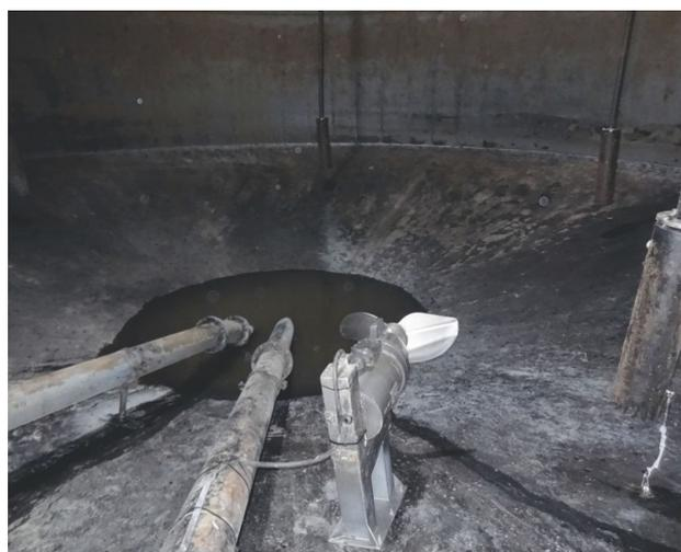
Entleerter Faulraum Nr. 1 mit Leitungen und Rührwerk
