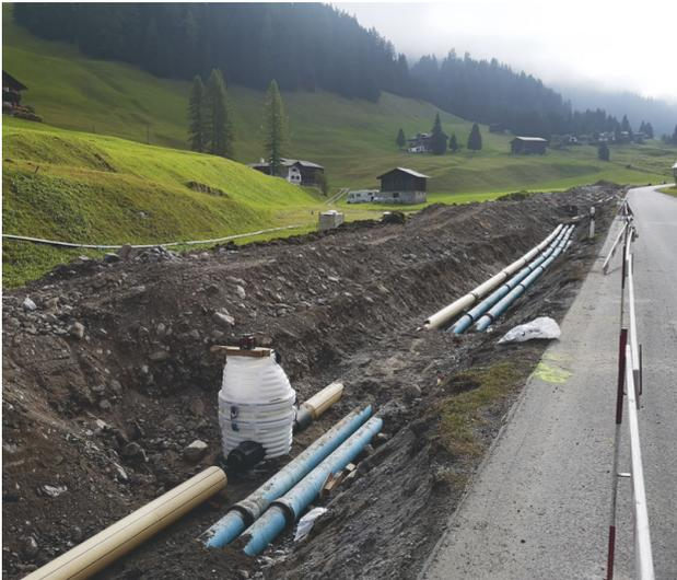
**Erschliessung Sertig mit brauner Kanalisation neben den Trinkwasserleitungen**
