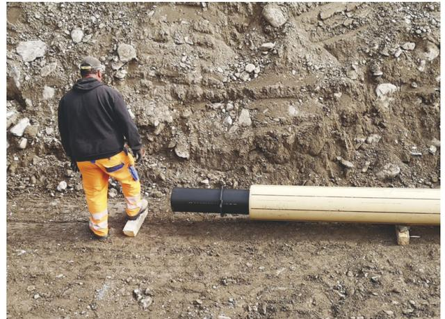
**Doppelwandiges Kanalisationsrohr (schwarz = Kanalisationsrohr, hellbraun = Hüllrohr)**
