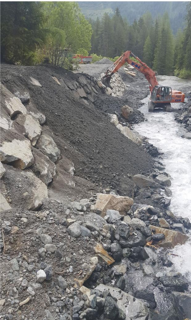
**Böschungssicherungen mit Blocksatz im Unterlauf**
