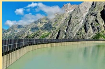
Mit Solarzellen auf den Staumauern liesse sich zusätzlich Energie gewinnen. Ein solches Projekt wird am Albignasee im Bergell realisiert. An der 600 m langen Staumauer wird eine **Solaranlage** installiert. Diese liefert jährlich rund 500 MWh erneuerbaren Solarstrom. So wird die Stauanlage für die Stromproduktion vor Ort doppelt genutzt. Auch schwimmende PV-Inseln (Solarparks) sind auf Stauseen bereits realisiert worden.
