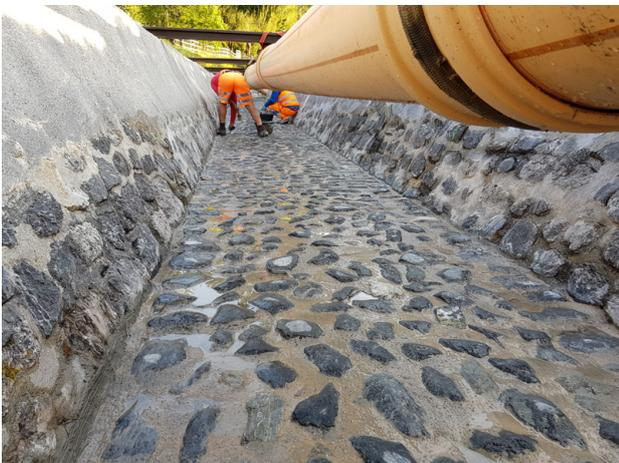
**Im trockenen Kanal wurden die Mauerfugen an der Sohle und in den Seitenwänden frisch vermörtelt**
