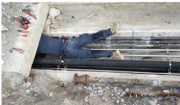
**Einbauarbeiten der neuen Fernleitungen bei teils engen Platzverhältnissen**
