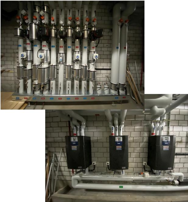
Die Sporthalle Arkaden ist an das EWD-Fernwärmenetz (Grundwasserwärmepumpen) angeschlossen. Die neue Heizungsverteilung versorgt die Sporthalle Arkaden und das neue Kulturzentrum auf dem Arkadenplatz. Die alten Warmwasserboiler wurden durch Frischwasserstationen ersetzt. Diese Art der Warmwasseraufbereitung verhindert die Bildung von Keimen, die zur gefürchteten Legionärskrankheit führen können.
