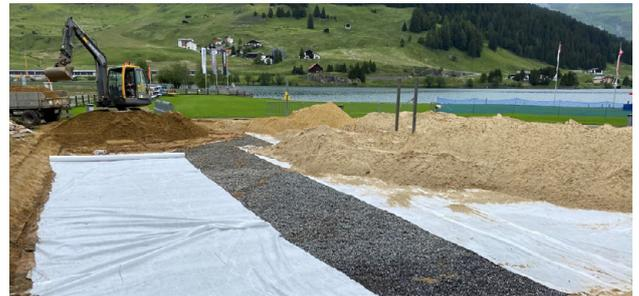
Der Unterbau und die Umrandung wurden komplett erneuert. Der frisch eingebrachte Sand erfüllt die Spezifikation von Turnierplätzen. Der Platz wird sehr rege genutzt, und die Rückmeldungen der Spieler sind durchgehend positiv.
