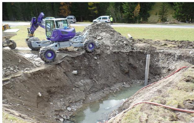
Standort des Entnahmebrunnens und der Kiespackung beim Bau
