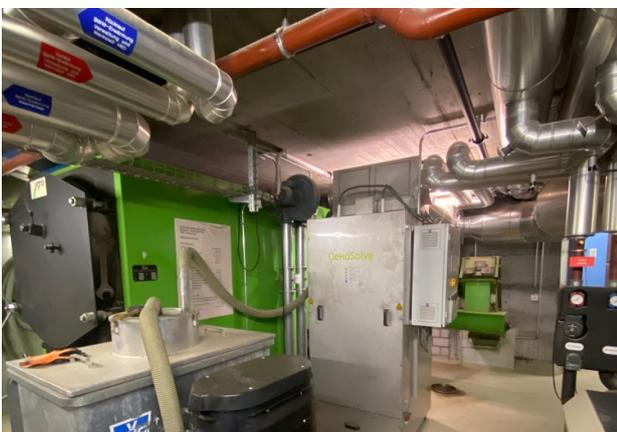
Die neue Filteranlage verhindert, dass Feinstaub aus dem Verbrennungsraum über den Rauchabzug in die Umwelt gelangt.
