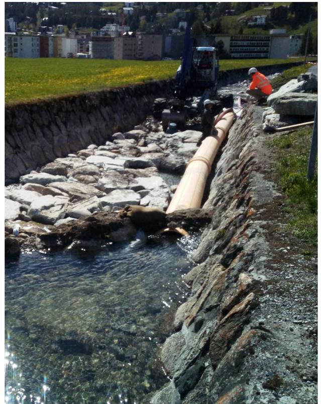
**Sanierung der Bachsohle mit Wasserhaltung**
