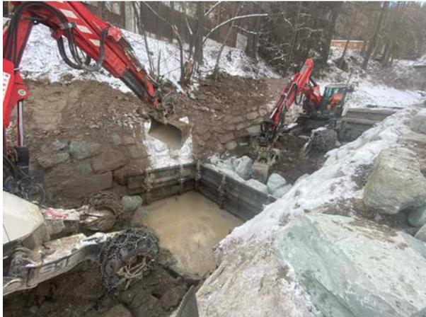
*Sohlensicherung bei den Stahlsperren (Foto MH)*
