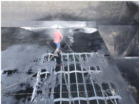
*Ausspritzen der und reinigen der Vorklärung, um die Beschichtung zu kontrollieren*
