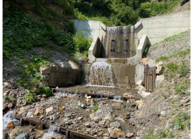
*Betonsperre mit seitlicher Flankensicherung und beinahe eingedeckter Vorsperre aus Stahl (Foto MH)*
