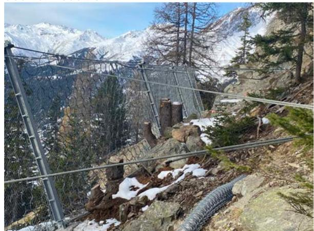
Neues Steinschlagschutznetz 1'000 kJ (Foto MH)
