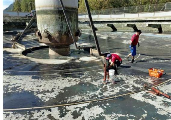
*Ganz zum Schluss steht jeweils die Arbeit an den Nachklärbecken an. Auch da werden mit viel Wasser die Becken abgespritzt. Abgenutzte Teile wie Rollen und Gummibänder werden ausgewechselt. Sämtliche Dilatationsfugen und Beschichtungen werden genau kontrolliert*
