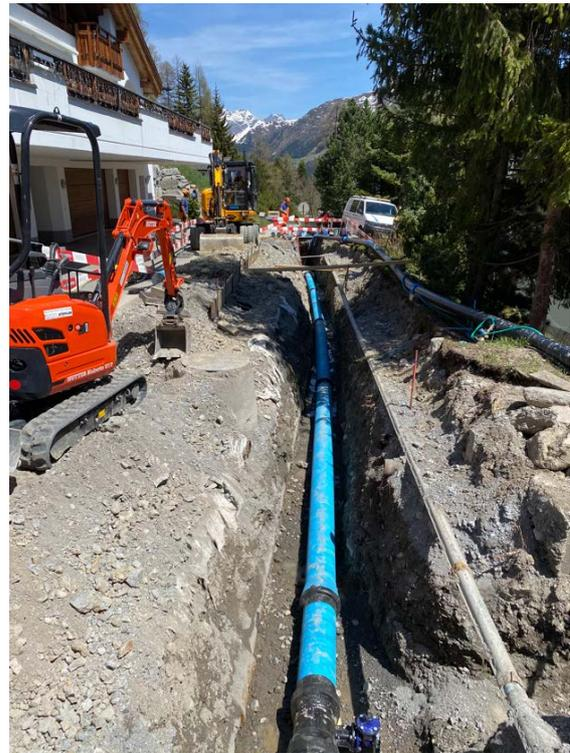
*Enge Platzverhältnisse für die Sanierung der Börtjistrasse. Die neue Trinkwasserleitung (blau) ersetzt die Wasserleitung aus dem Jahr 1911*
