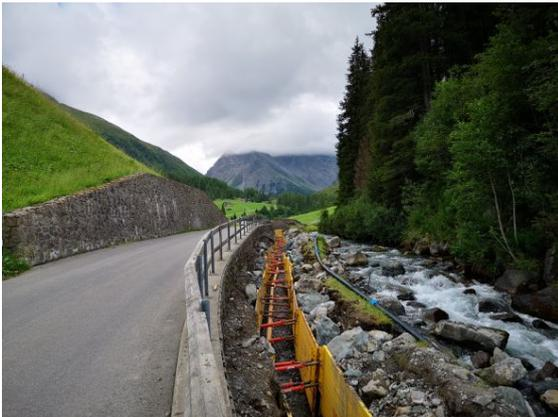
*Sertig Bäbi: gespriesster Graben für Trinkwasser- und Kanalisationsleitung. Der schwarze Schlauch ist das Provisorium für die Trinkwasserversorgung*
