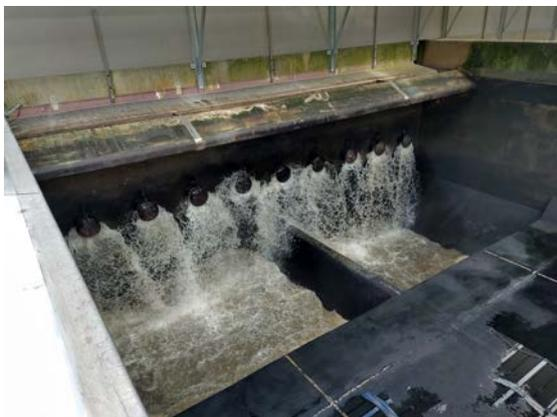
*Befüllen der Vorklärung nach der Reinigung, für welche 3 Tage pro Becken benötigt werden*
