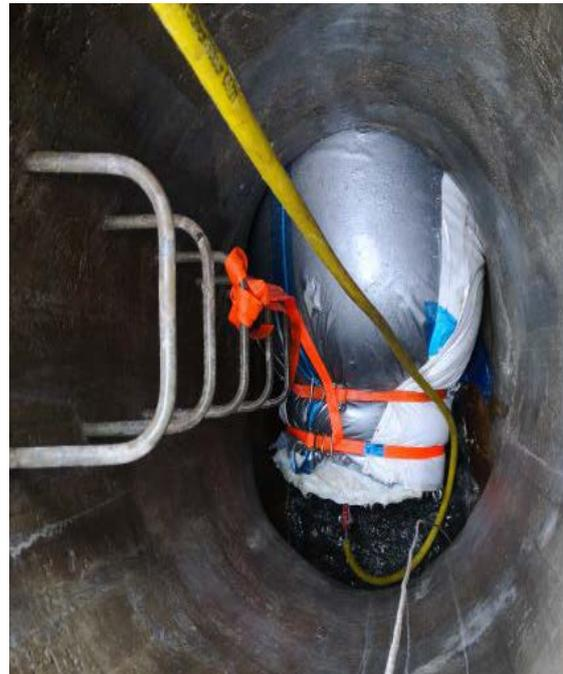
*Eingepresster Kunststoffschlauch im Rahmen des Inlinerverfahrens*
