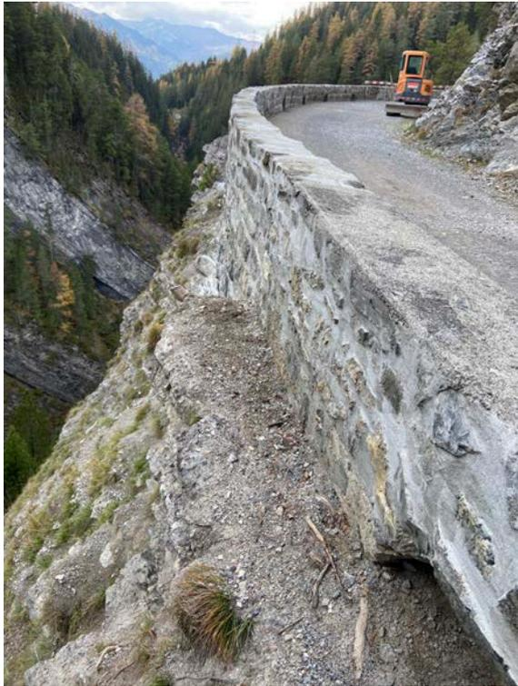
*Sanierte Stützmauer am Abgrund der Zügenschlucht*
