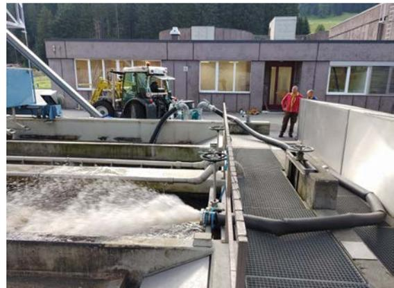
Leeren des Sandfettfangs Strasse 1 mit der mobilen Bürgerpumpe welche über die Zapfwelle des Traktors angetrieben wird.
