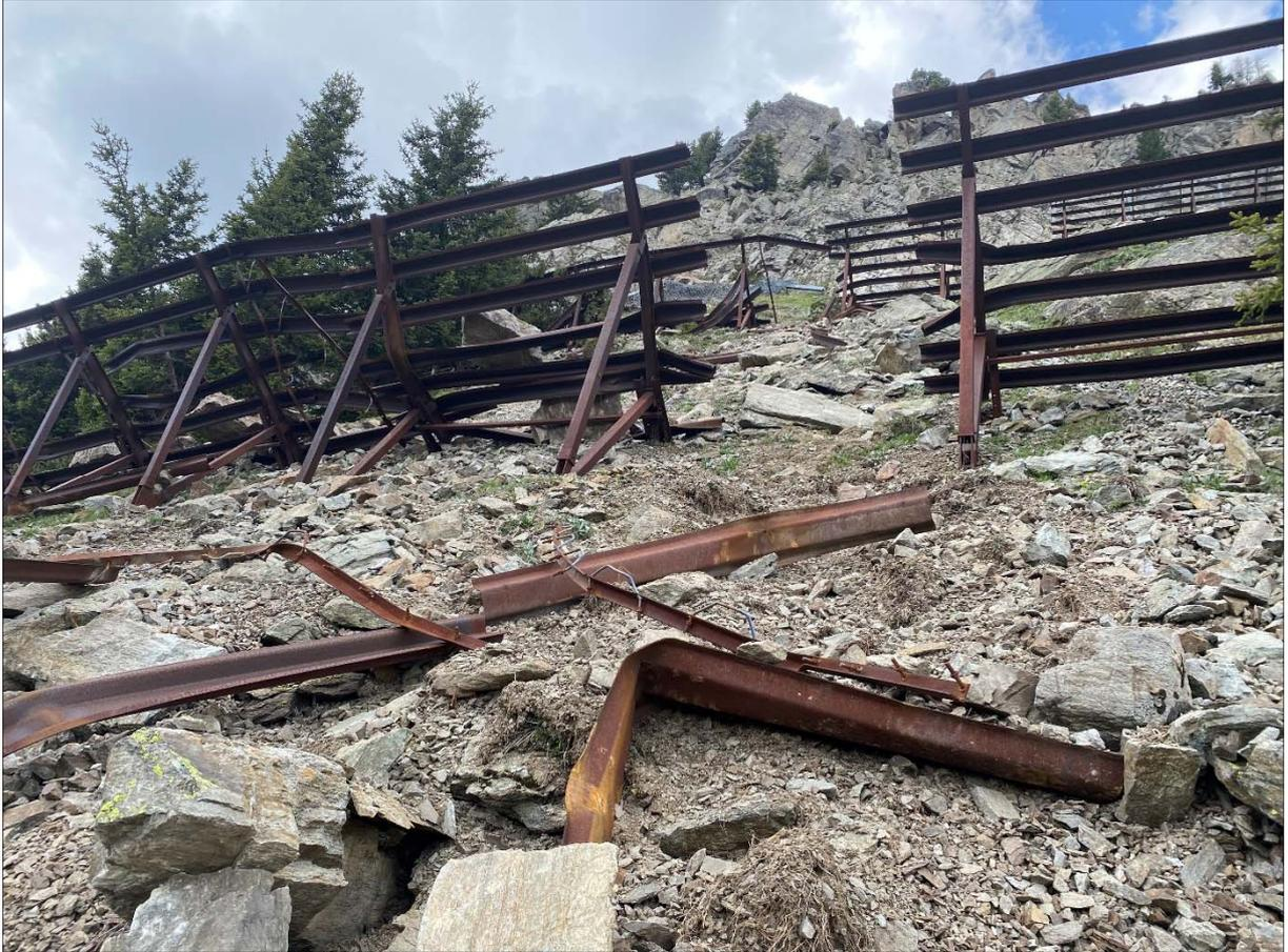
*Beschädigte Lawinenverbauung und zerstörtes Steinschlagnetz Nr. 18 im Hintergrund*
