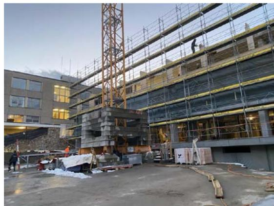
*Aufstockung und seitliche Erweiterung erfolgt mittels Holzkonstruktion*
