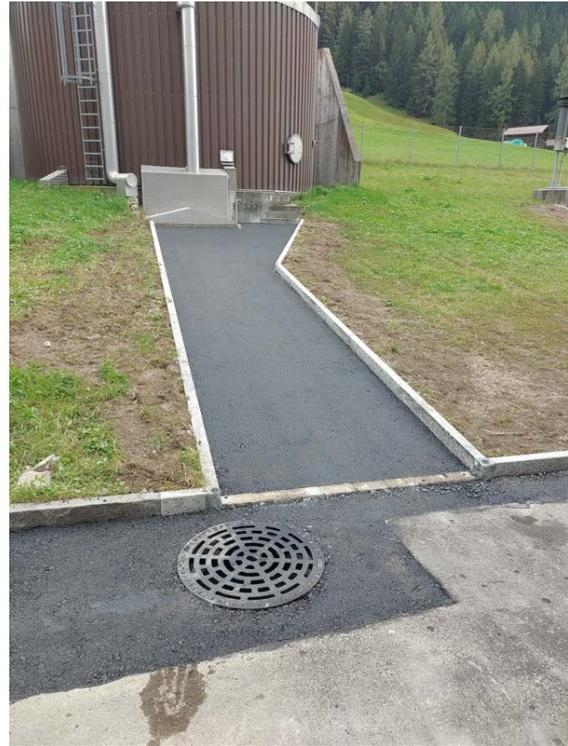
Zu verschiedenen betriebsnotwendigen Anlagen wurden die alten Bodenplatten entfernt und ein Asphaltbelag eingebracht.
