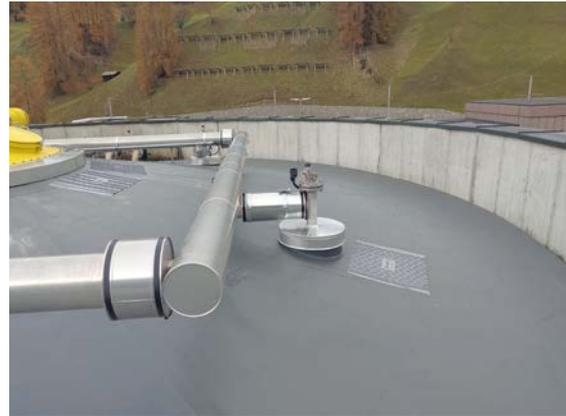
Abgeschlossen wurde die Dämmung mit einer speziellen Folie welche komplett verschweisst wurde.
