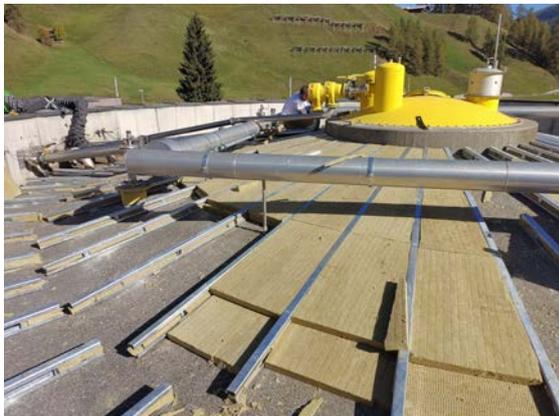
Zwischen das Traggerüst wird die Dämmung eingebaut
