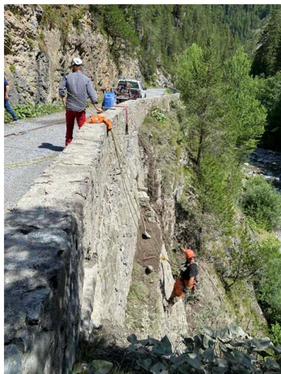
*Arbeiten am hängenden Seil zur Erhaltung der talseitigen Stützmauern*
