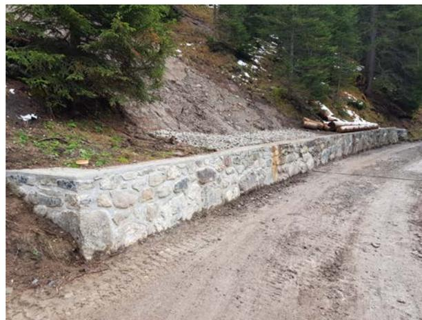
Bergseitige Mauer mit Entwässerung (Foto MH)
