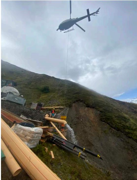
Betonieren der Sperre mit Heli (Foto MH)
