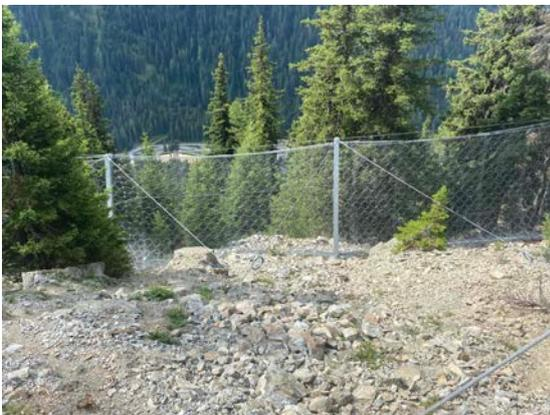
Neues Steinschlagschutznetz 3'000 kJ (Foto MH)
