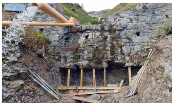
Sperr Nr. 19 musste mit Beton unterfangen werden (Foto UB)
