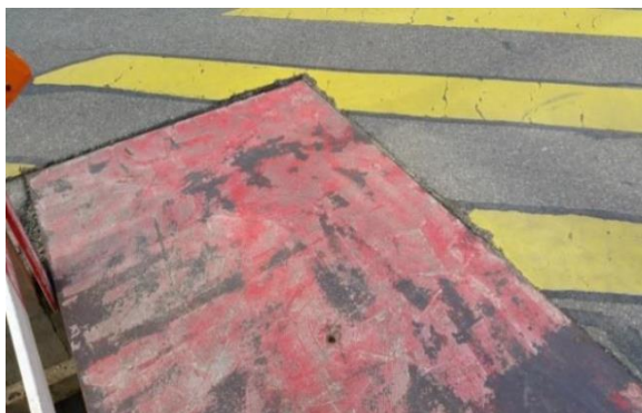
Versenkte Stahlplatte in Fahrbahn
