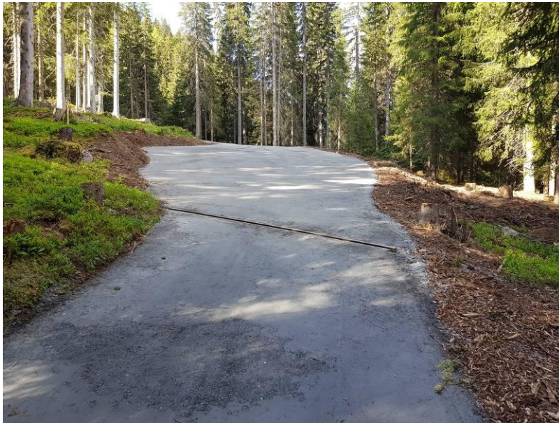
1.5 Stat. 200-230 m: Fertige Naturstrasse, Kehrplatz (02.06.20)
