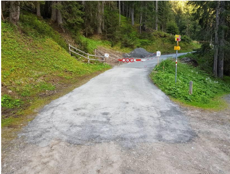
1.1 Stat. 0 m: Fertige Naturstrasse (02.06.20)
