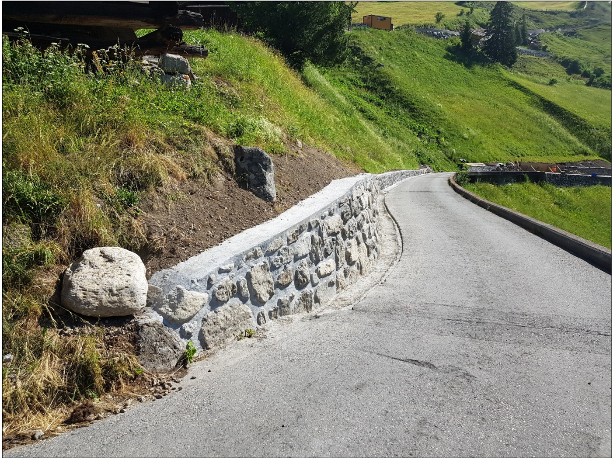
Mauersanierung zu Beginn der Silberbergstrasse.
