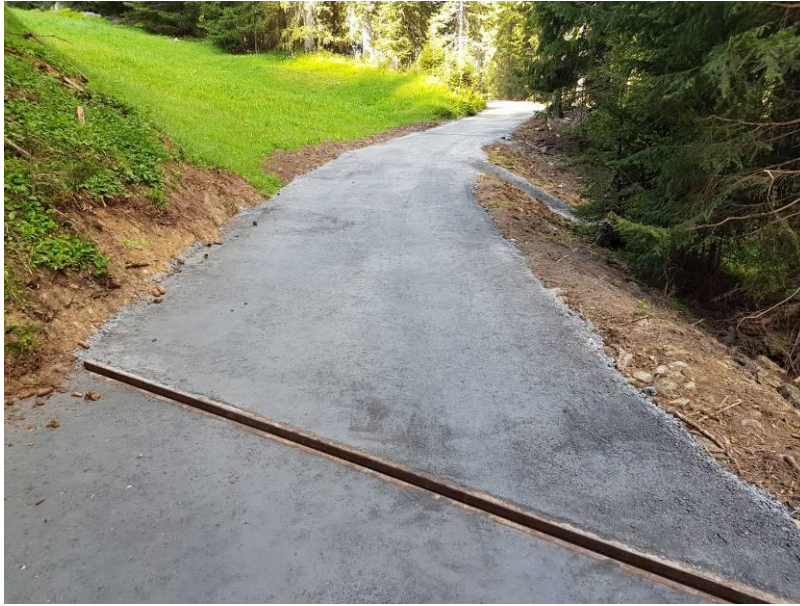
1.4 Stat. 145-170 m: Fertige Naturstrasse (02.06.20)
