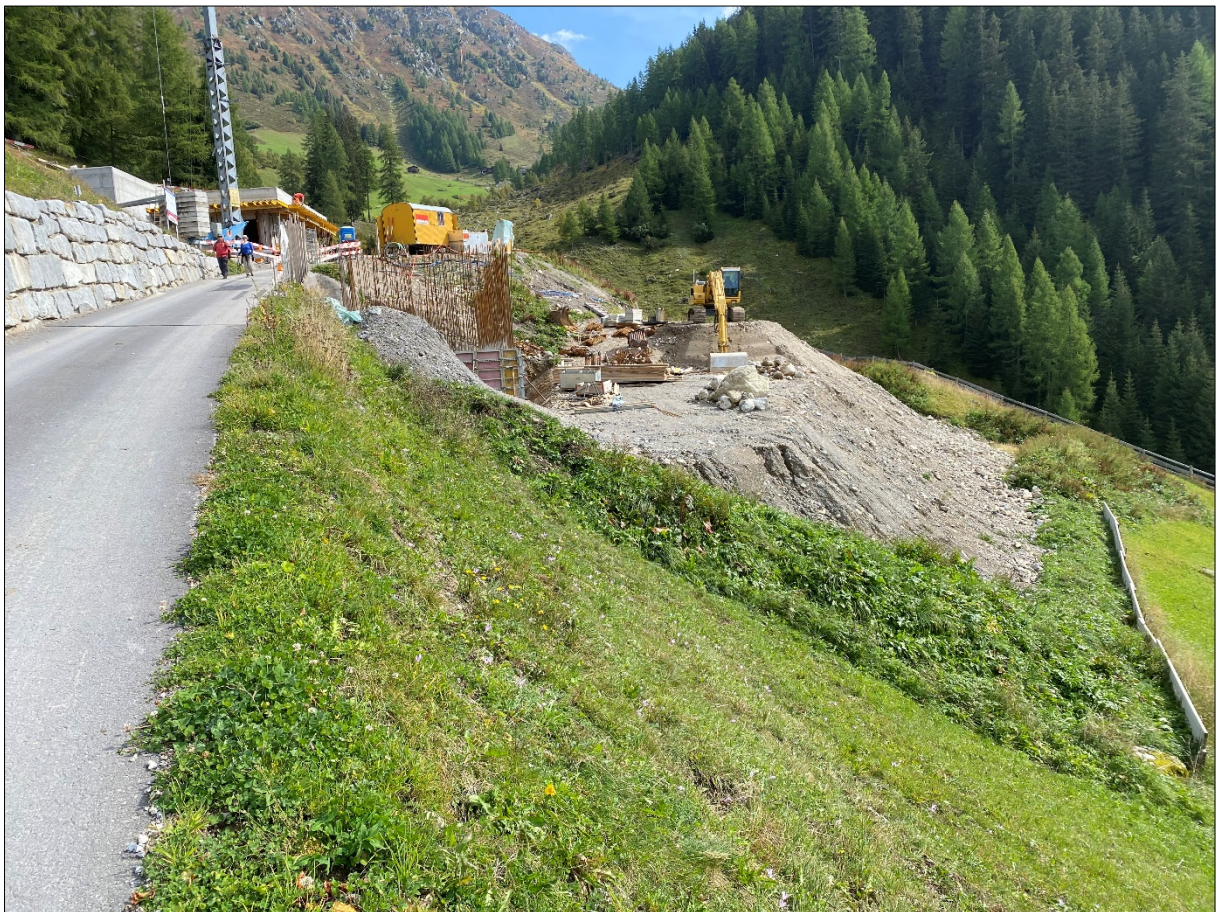
Waldstrasse erstellt, Bau des Löschwasserbeckens (Vordergrund) und des Reservoirs (Hintergrund).
