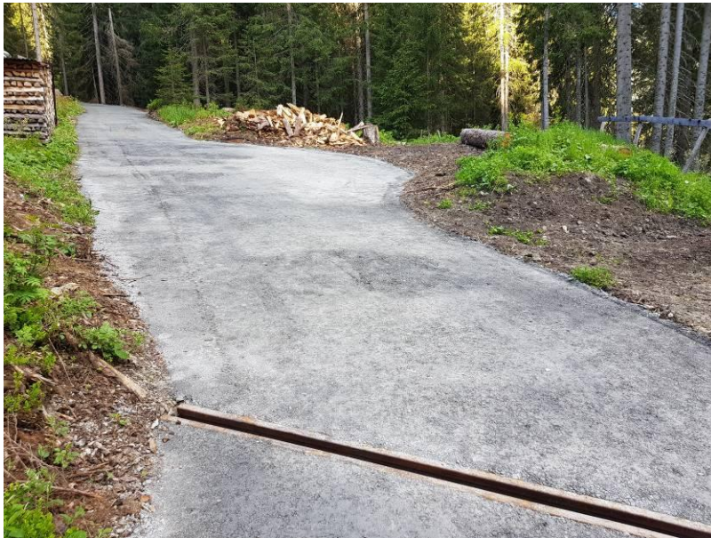
1.2 Stat. 50-85 m: Fertige Naturstrasse, kleine Ausweichstelle (02.06.20)
