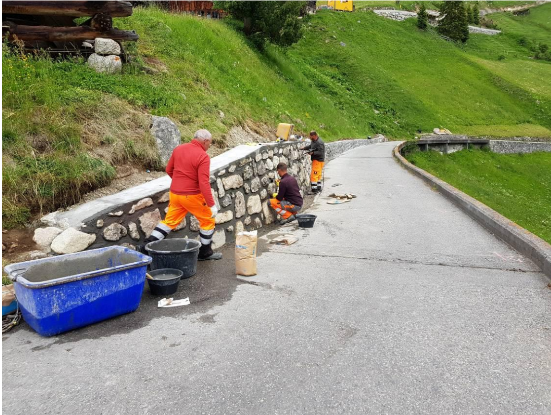
11.07.19: Fertig erstellte untere Bruchsteinmauer (Rigole später gebaut)
