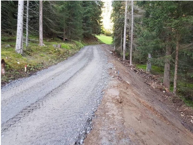
18.05.20: Eingebaute Fundations- schicht
