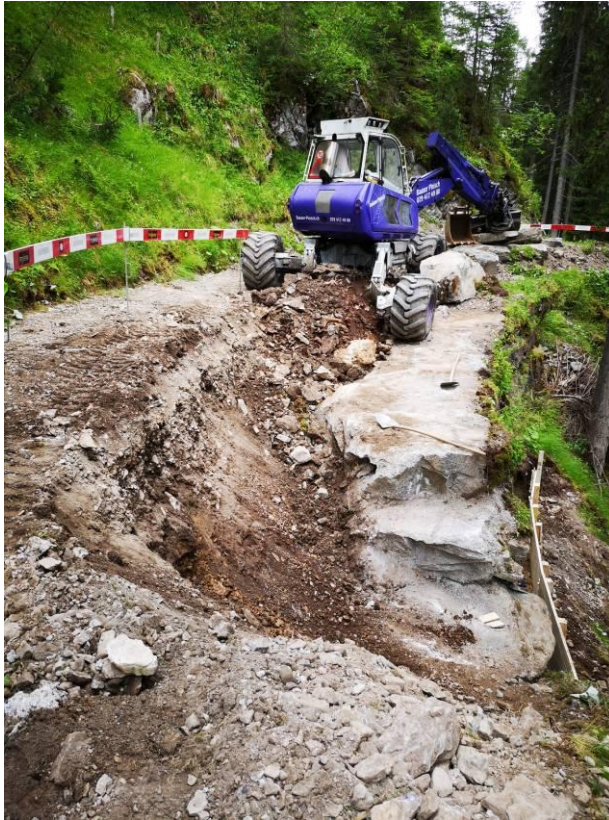
12.07.19: Schalung für Unterfangung (Foto: Implenja)
