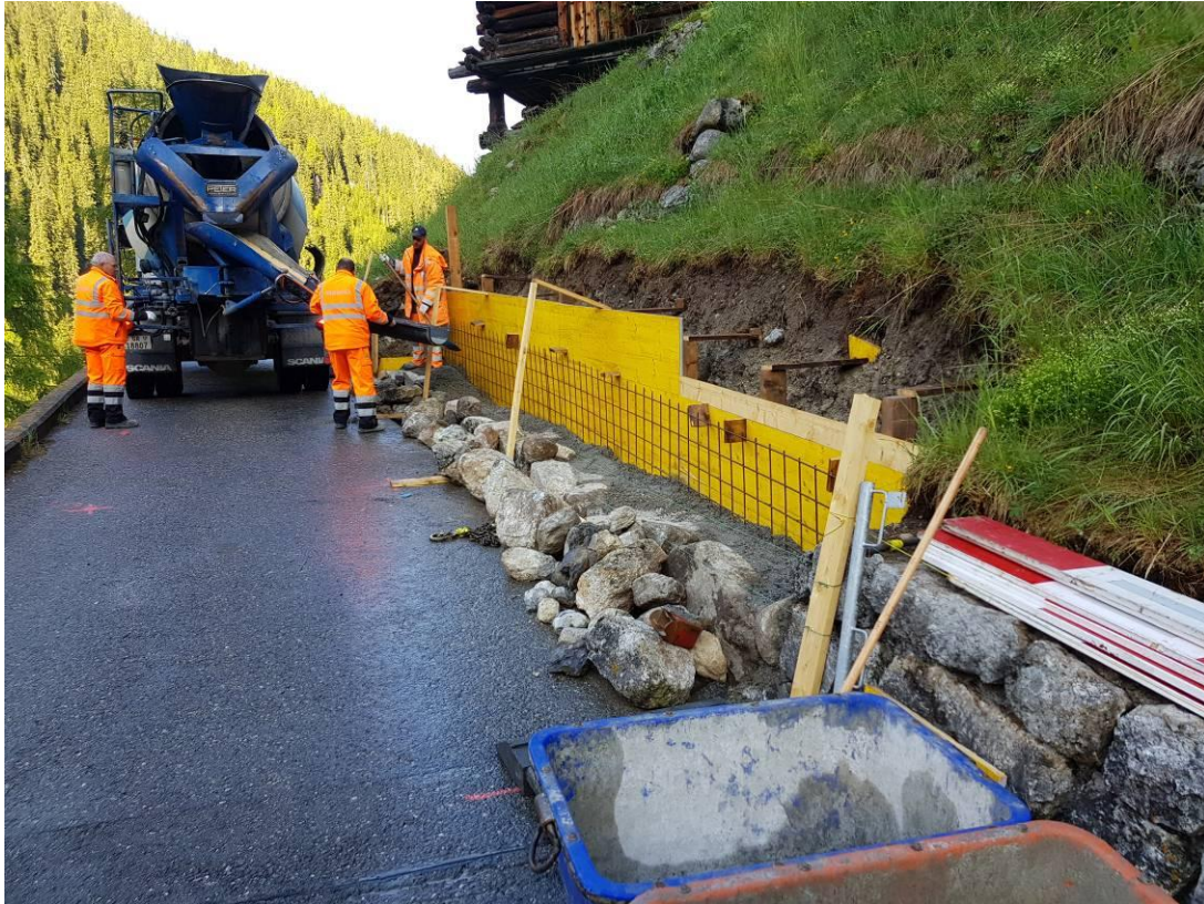
11.06.19: Bauarbeiten obere Bruchsteinmauer
