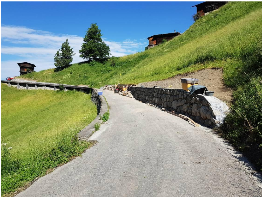
11.06.19: Bauarbeiten untere Bruchsteinmauer
