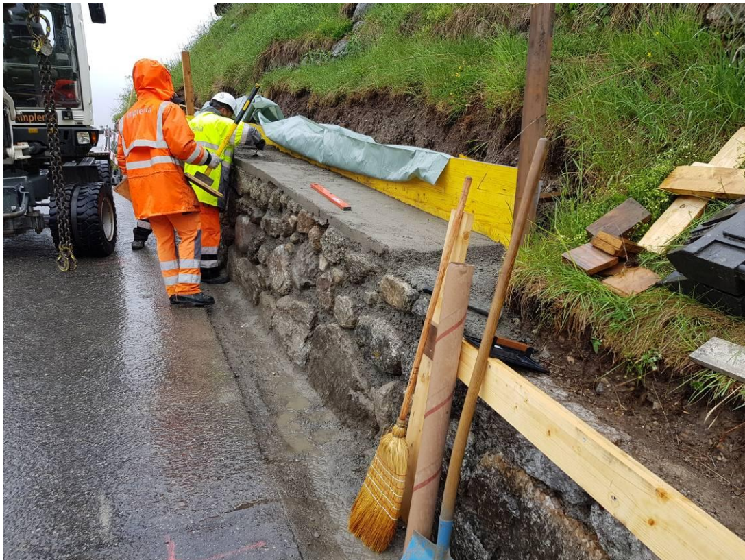
12.06.19: Erstellen der Mauerkrone mit Zementmörtelüberzug (obere Mauer)
