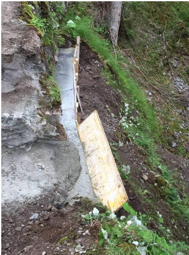
12.07.19: Betonunterfangung (Foto: Implenja)
