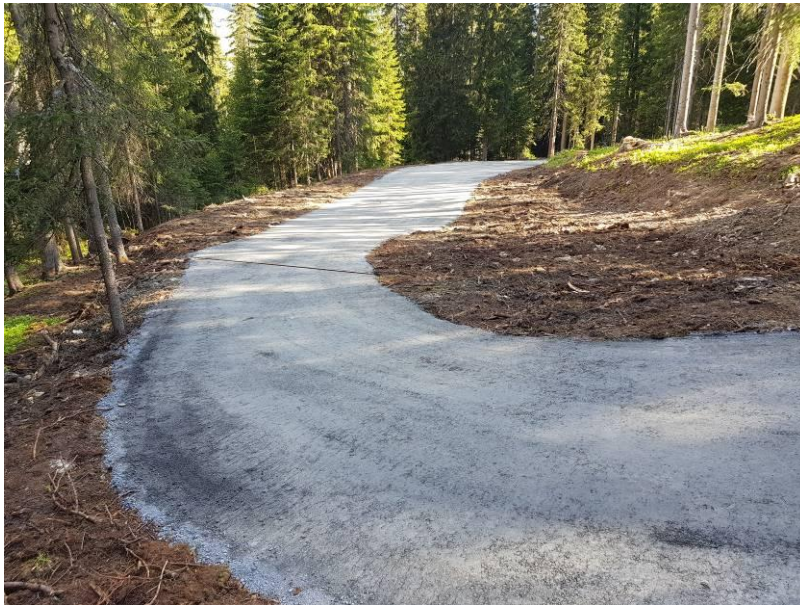
1.6 Stat. 230-270 m: Fertige Naturstrasse, Holzlagerplatz (02.06.20)
