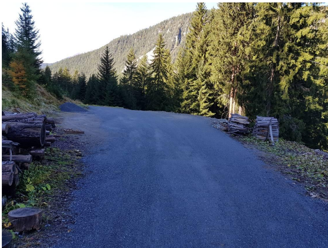
17.10.19: Fertig erstelle Verschleisschicht
