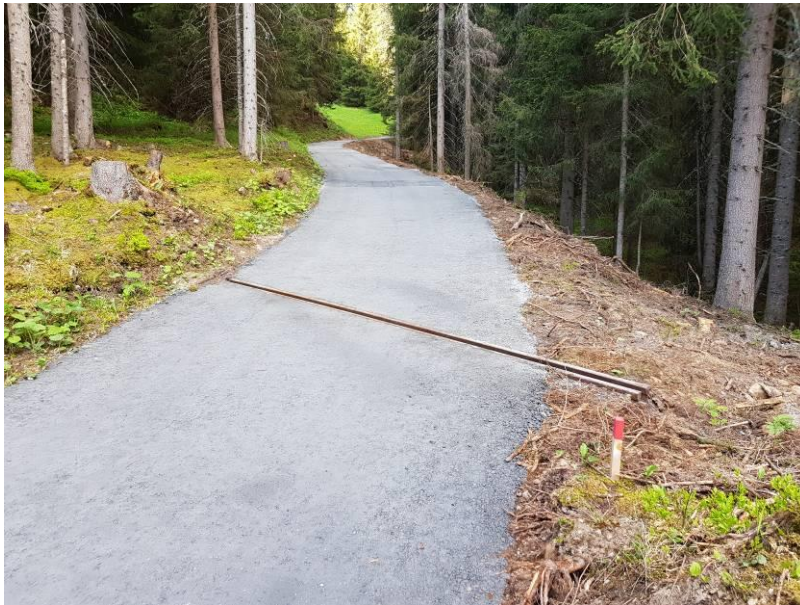
1.3 Stat. 85-145 m: Fertige Naturstrasse (02.06.20)
