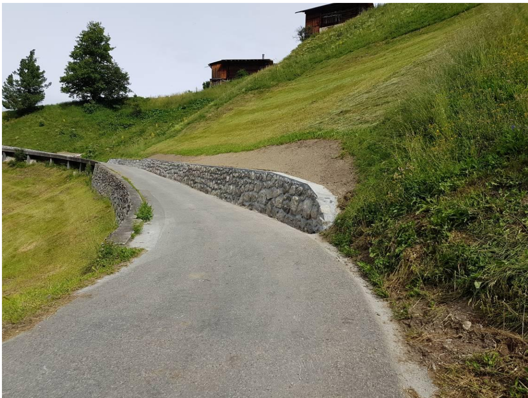
11.07.19: Fertig erstellte untere Bruchsteinmauer (Rigole später gebaut)
