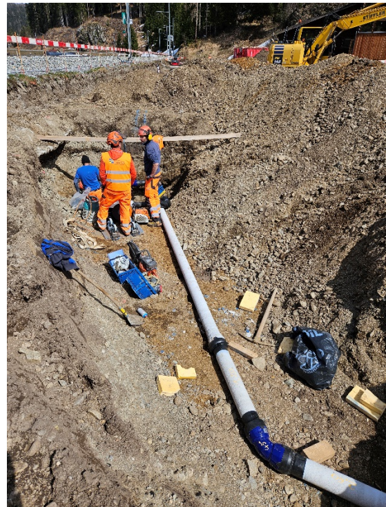
Die laufende Erneuerung der Trinkwasserleitungen setzte sich auch 2024 fort. Im Bild eine Baustelle in der Stilli.
