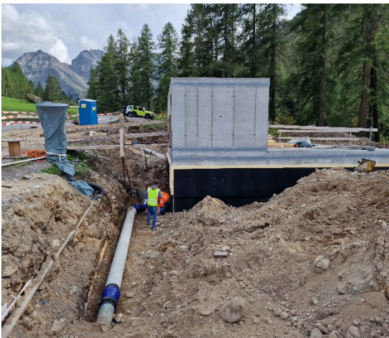
Bauarbeiten an der Pumpstation Bäbi
