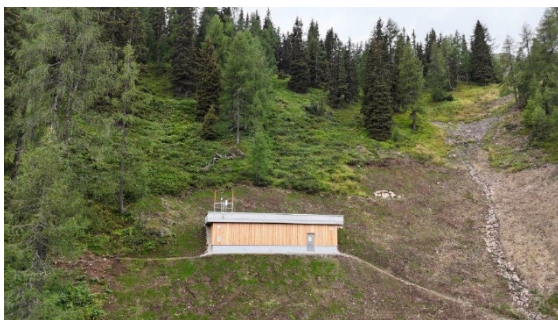
Der neue Hauptsammler befindet sich direkt neben der Besenbinder-Abfahrt.
