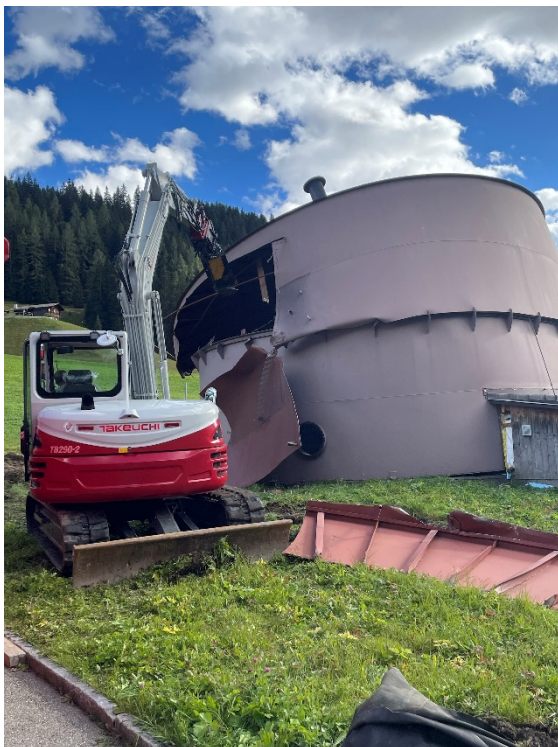
Abbruch des alten Gasometer-Gebäudes
