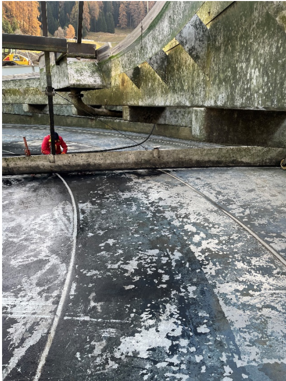
Kontrolle des Räumschildes in einem der beiden Nachklärbecken
