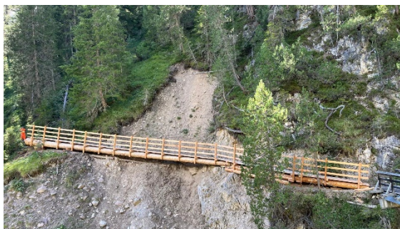
Neue Holzbrücke Mühlitobel
