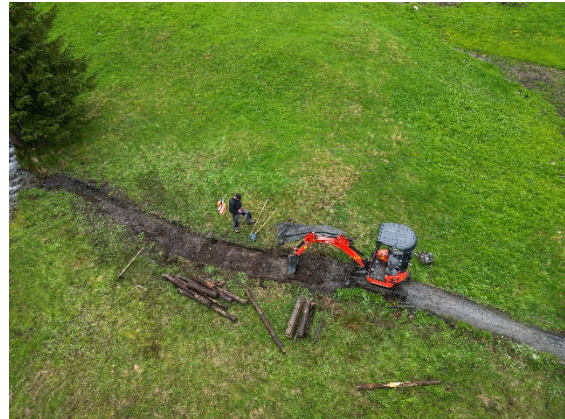
Unterhaltsarbeiten auf Wanderwege
