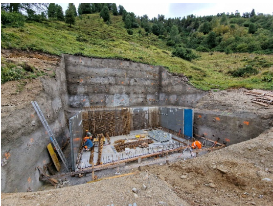
Baugrube des neuen Trinkwasser-Reservoirs oberhalb von Sertig Dörfli
