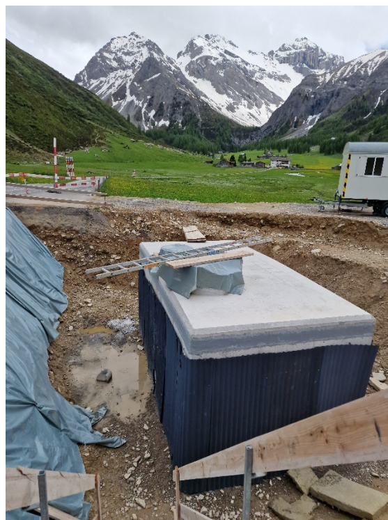
Rohbau des neuen Abwasserpumpwerks Sertig Dörfli zwischen dem Dörfli und Sertig Sand
