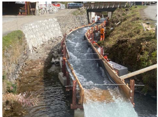
Saubere Wasserhaltung und erstellte Mauer 1.7 (Foto MH)
