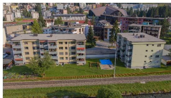
Die Wohnliegenschaft Riedstrasse 14, 14A und 16 mit insgesamt 30 Wohneinheiten.
