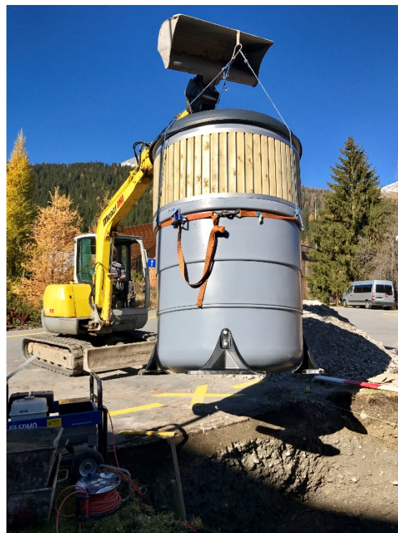
Installation Molok-Behälter
