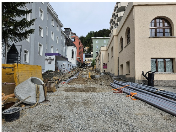
Der obere Teil der Tobelmühlestrasse wurde saniert, inklusive der darin verlaufenden Trinkwasserleitungen.
