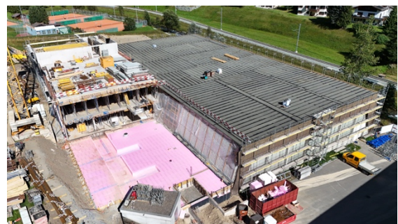
Der Rohbau des Anbaus zur Hälfte erstellt
