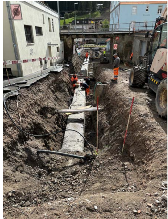
Beengte Platzverhältnisse forderten alle Beteiligten.
