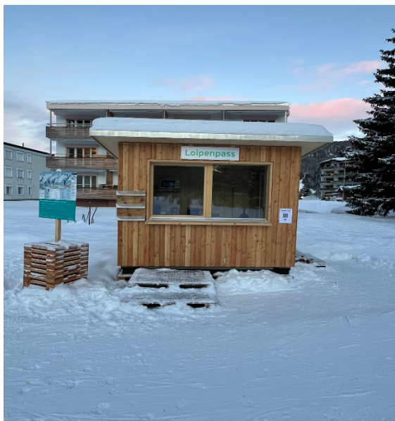
Neu erstelltes Loipenhäuschen beim Langlaufzentrum
