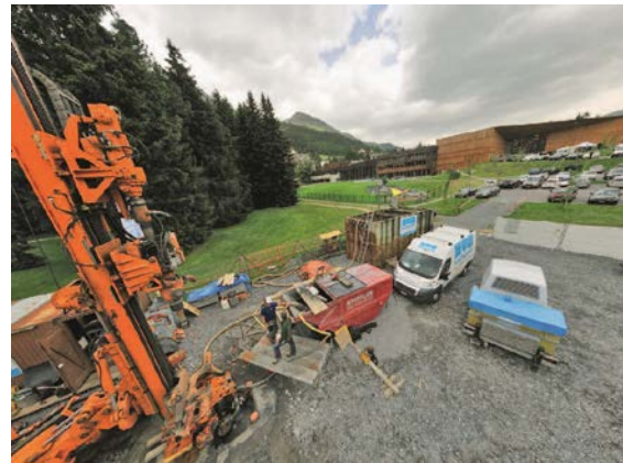
Bohrstelle im Kurpark
