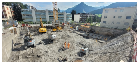
Baubeginn im Juni 2024
