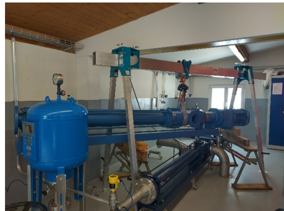
Die Auswechslung und die Inbetriebnahme der Exzentrerschnecken wurde durch die Mitarbeiter der ARA Davos ausgeführt.
