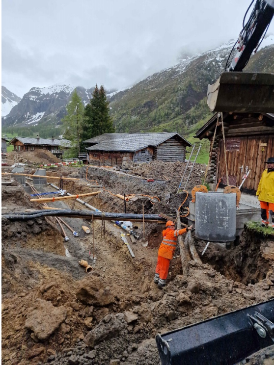
Werkleitungsarbeiten innerorts in Sertig Dörfli
