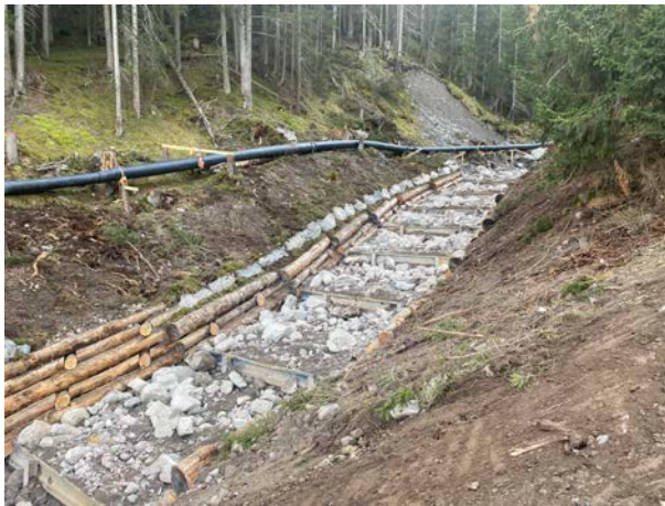
Bachverbau mit Holzkasten und Querriegel (Foto MH)
