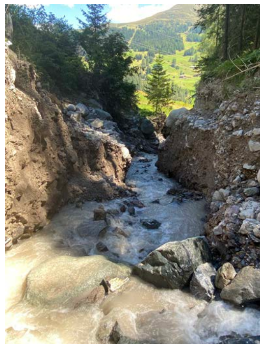
Tiefenerosion der Bachsohle über 2.0 m (Foto MH)
