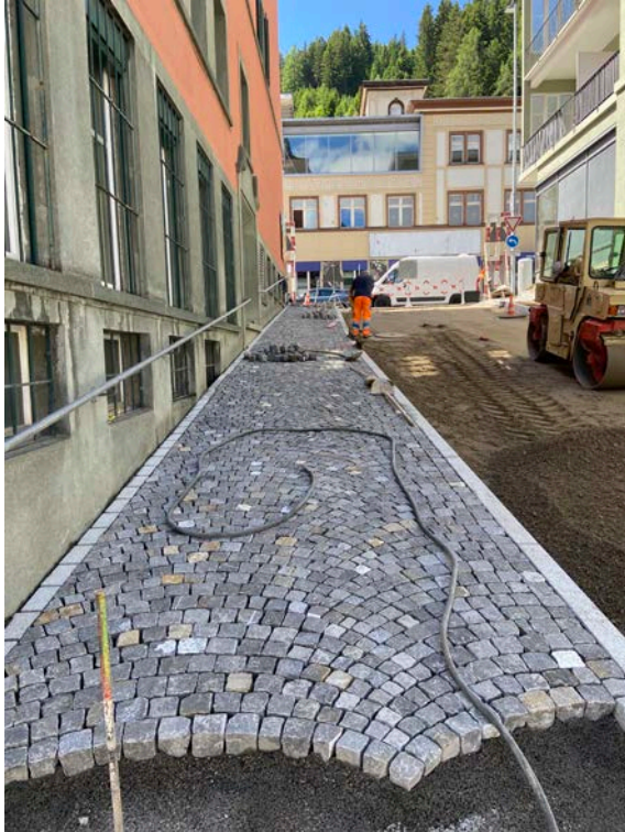
Das Trottoir entlang der Tobelmühlestrasse wurde erneut mit einer Pflasterung gestaltet und setzt damit einen attraktiven Kontrast zu den überwiegend dunklen Belagsflächen im Zentrum von Davos.
