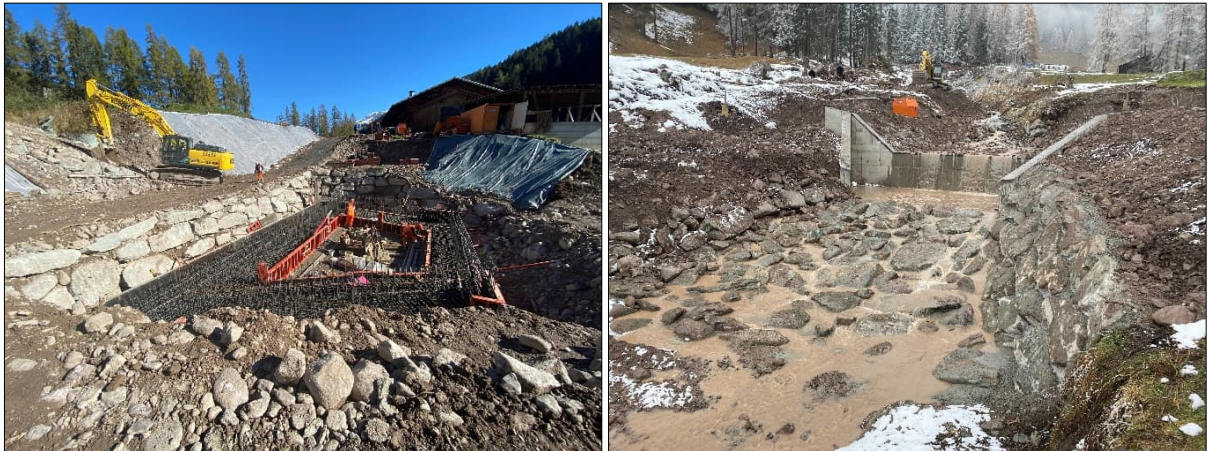
Abbildung 3: Bau der Betonsperre
