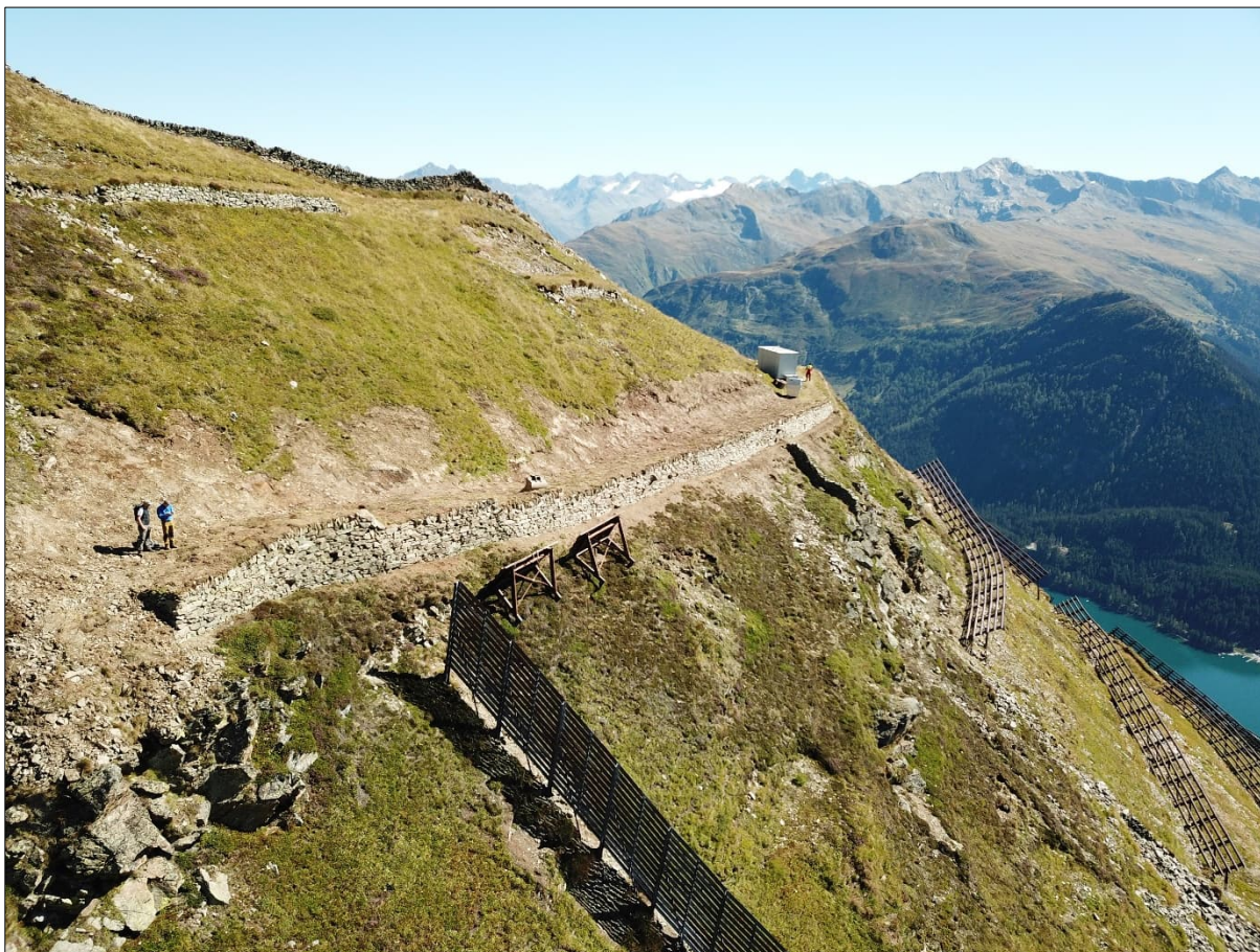
Sanierte Mauer 104 bei der Bauabnahme
