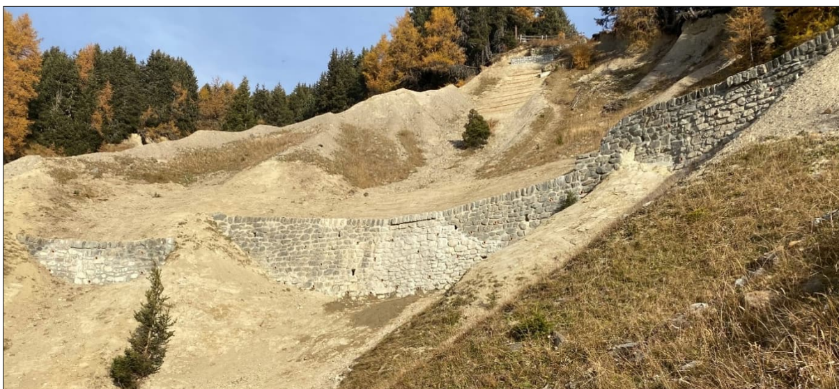
Saniertes Sperrbauwerk S9, Oktober 2021.
