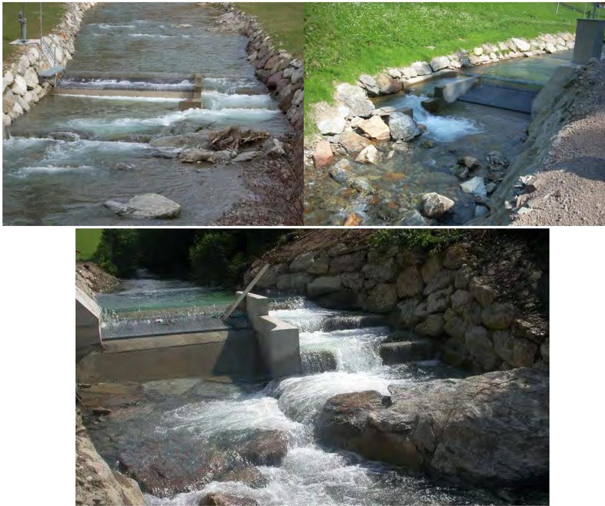
Abbildung 14 Beispiele von Wasserfassungen mit simultan dynamischer Dotierung.
