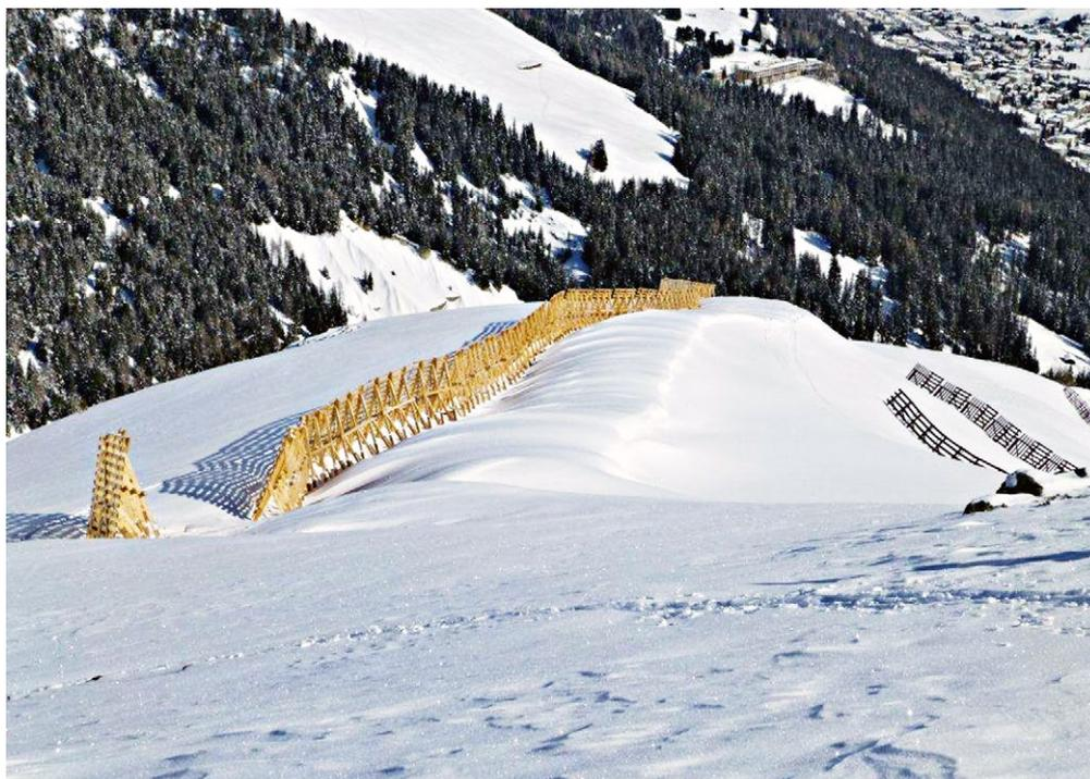
Mit einer Verwehungsverbauung kann die Ablagerung des Triebsschnees beeinflusst werden. Ohne Verwehungsverbauungen wären die Stahlschneebrücken in der rechten Bildhälfte mit Triebsschnee überdeckt und könnten die Schutzfunktion nicht mehr erfüllen.
