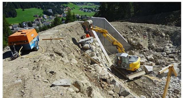
Aufbringen des Erosionsschutzes durch Blocksteine neben dem Auslaufbauwerk
