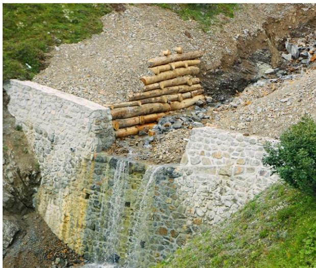
Sanierte Sperre inkl. Leitwerk aus einem Holzkasten
