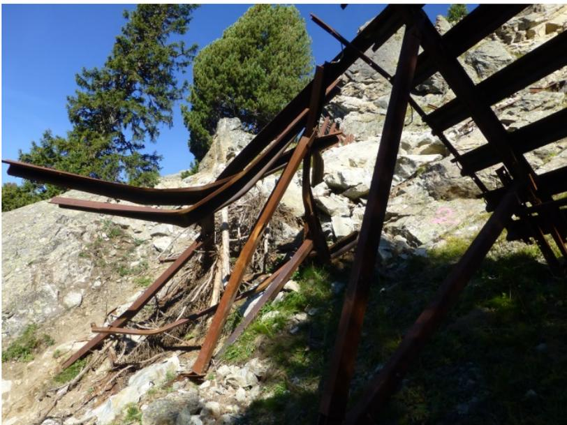
Werkreihe 40: 1 Werk komplett zerstört, mit Felsmaterial hinterfüllt.
