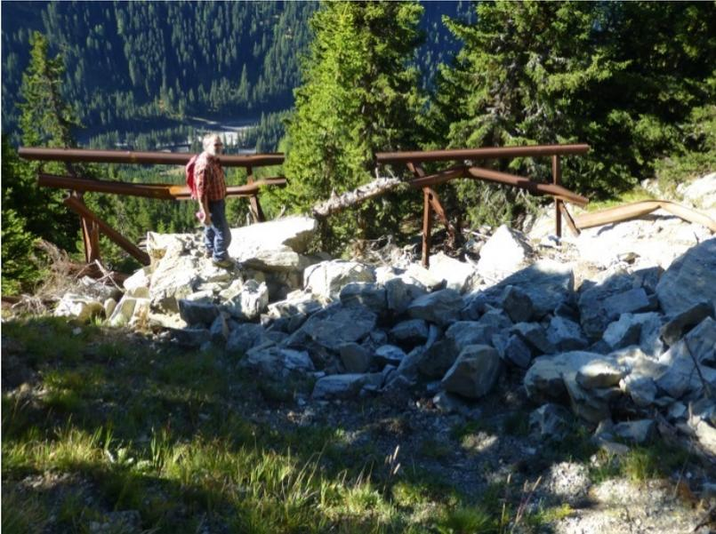
Werkreihe 43: 2 Werke zerstört, mit Material hinterfüllt.
