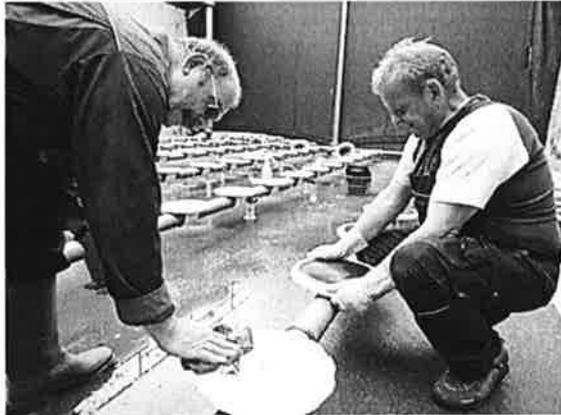
Reinigung eines Grundkörpers und Montage einer neuen Membran (schwarz).
