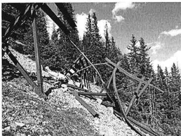
Durch den Felssturz total beschädigte Stahlschneebrücke
