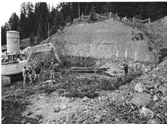
*Baugrubenaushub für das neue Reservoir Parsenn*
