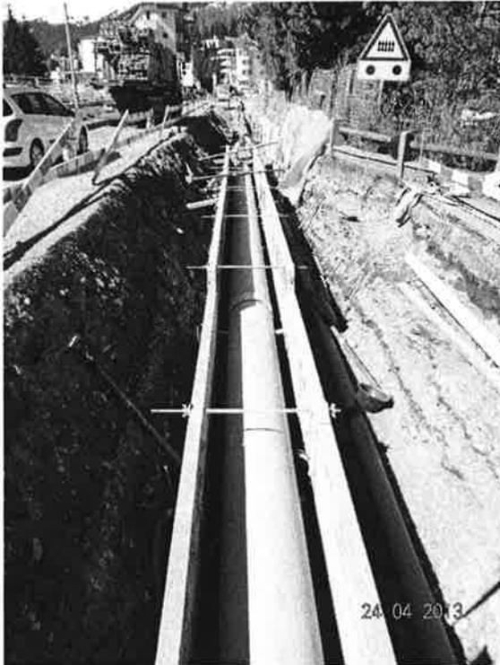
*Neu verlegte Abwasserleitung in der Flüelastrasse*
