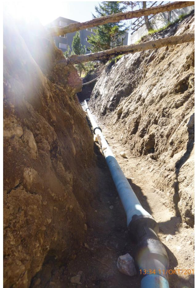
**Umgelegte Trinkwasserleitung unter bestehenden Werkleitungen**
