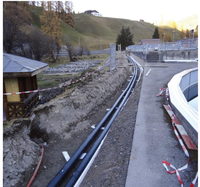
Verlegung der beiden Glykoleleitungen für den zukünftigen Wärmetransport in Richtung Wärmepumpen
