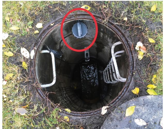
Fertig installierter Prozesswächter in einem Kontrollschacht
