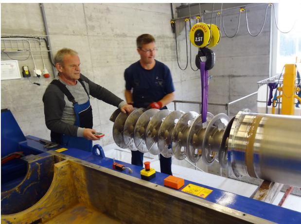
Einsetzen der Trommel in die Zentrifuge durch Mitarbeiter der ARA und Spezialisten
