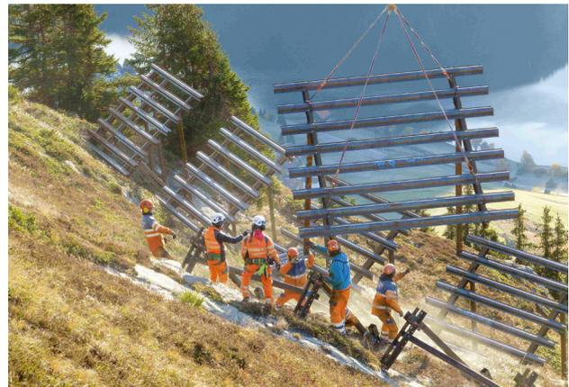
Helikopterunterstützter Aufbau einer fertig montierten Stahlschneebrücke (Foto A. Guler)
