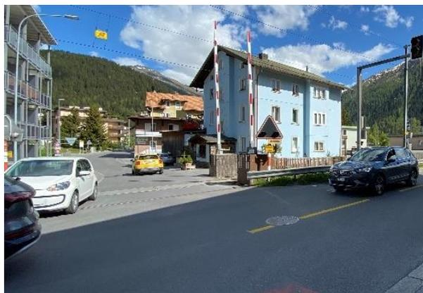
Abbildung 64: Aufnahme des bestehenden Knotens: Die Sichtverhältnisse für Fahrzeuge aus der Dischmastrasse sind kritisch
